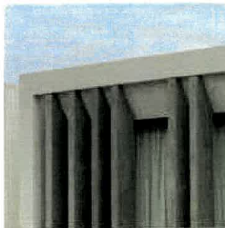
CONCRETE FINS EXTERIOR
